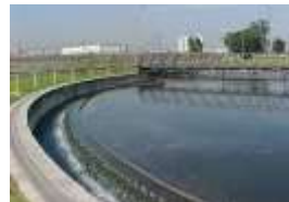
Decantador Secundário Circular.
