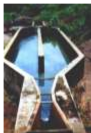
Caixa de Areia com velocidade controlada por Caixa Parshall.
