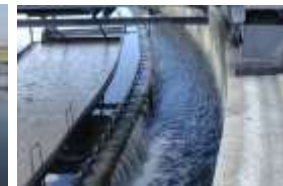
Decantador Secundário Circular. Detalhe do Vertedor.
