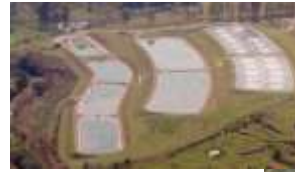
ETE São João (São João da Boa Vista). Lagoa Aerada seguida de Lagoa de Decantação e Lagoa de Secagem.
